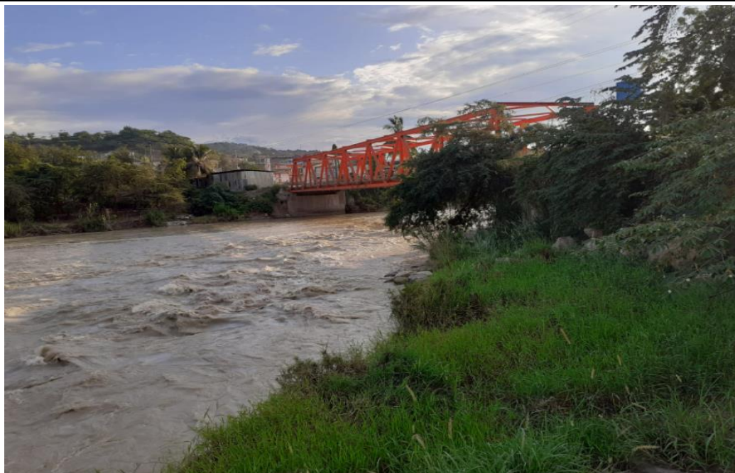
FIGURA N°01: TRAMO CRÍTICO EN EL PUENTE CAJARURO PRESENTADO EROSION EN LA MARGEN IZQUIERDA DEL RIO UTCUBAMBA EN EL SECTOR PUENTE CAJARURO, DISTRITO DE BAGUA GRANDE, PROVINCIA UTCUBAMBA - AMAZONAS.
